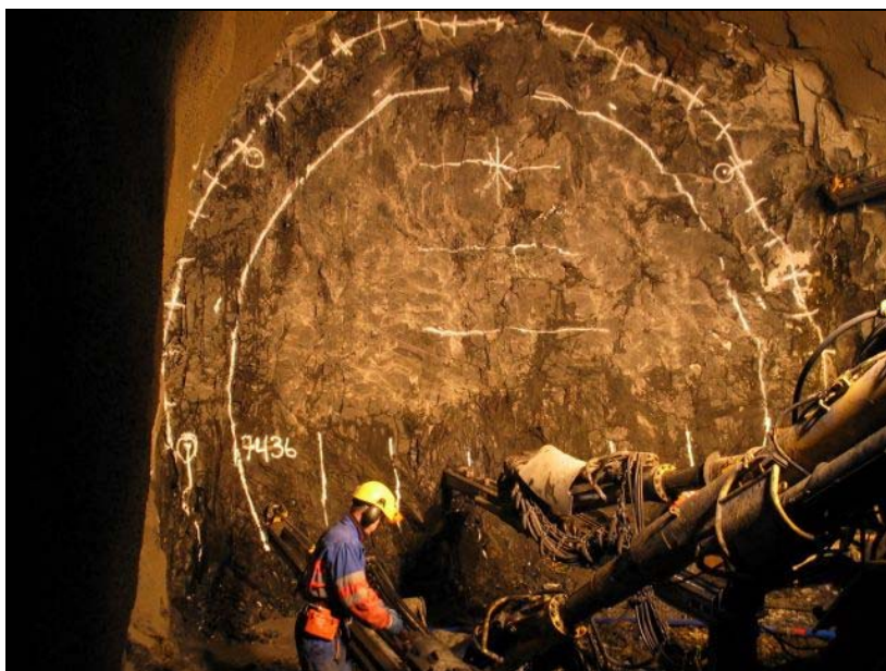
Mynd 4.2.1. Hleðsla og borun í Fáskrúðsfjarðargöngum (Ljósmynd: Sigurður Oddsson, maí 2004).
