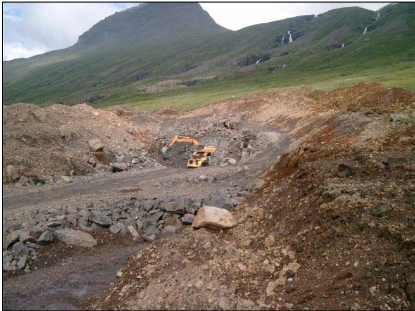
Mynd 4.2.2. Unnið í forskeringum í Fáskrúðsfirði (Ljósmynd.: Sigurður Oddsson, júní 2003).
